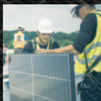
Montaż modułów Module installation
