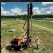
Palowanie i grodzenie Piling and fence installation
