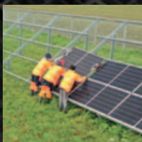
Montaż konstrukcji Structure assembly
