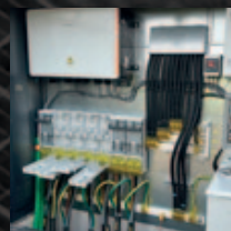
Instalacja Trafostacji Trafostation installation
